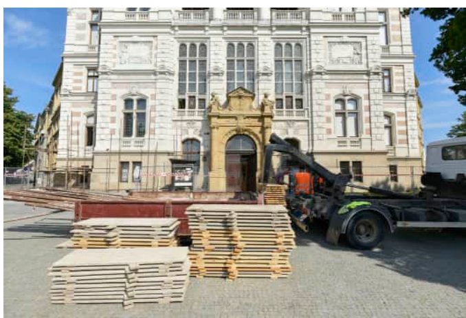
Oprava fasády Hlavní budovy ZČM
