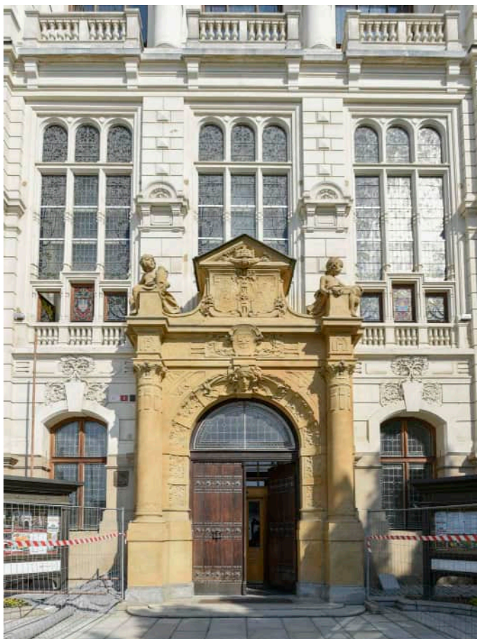
Oprava fasády Hlavní budovy ZČM
