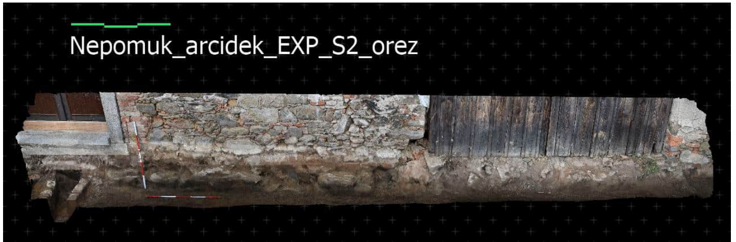
Obr. 3: Nepomuk - 3D model výkopu podél rekonstruované budovy. Na modelu je patrný starší (již nefunkční) cihelný kanálek, rozšíření základu současné budovy a struktura nadzemního zdiva. Autor: M. Loukota.
