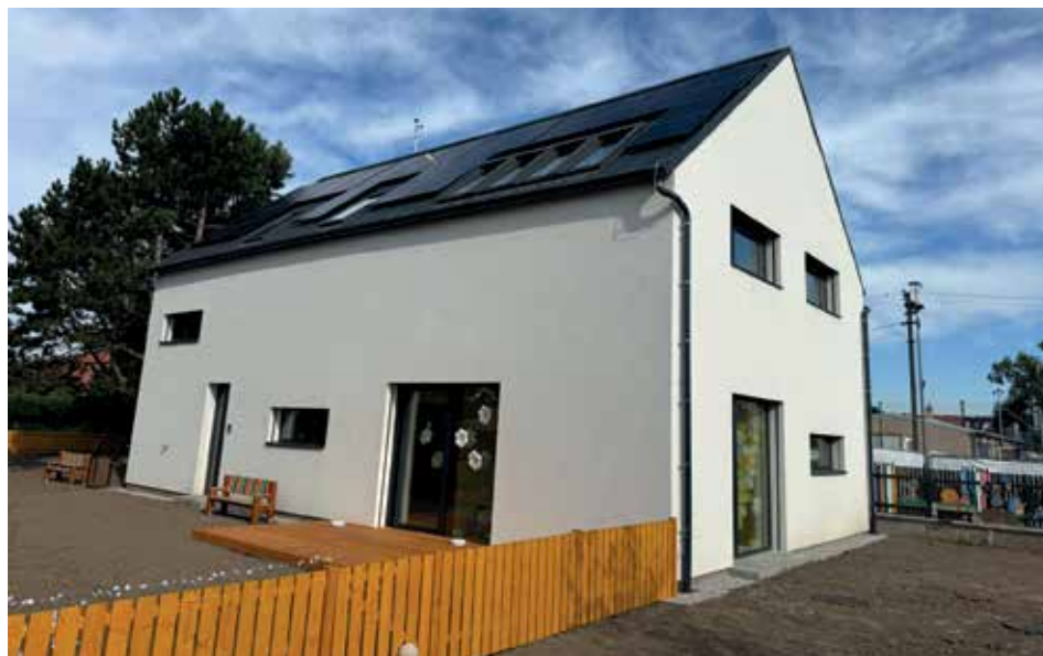
Nová budova ve Městě Touškov
