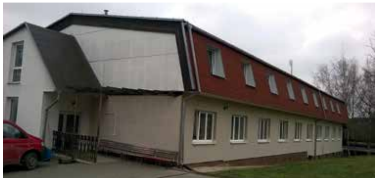
Budova DOZP Stod před a po rekonstrukci.
