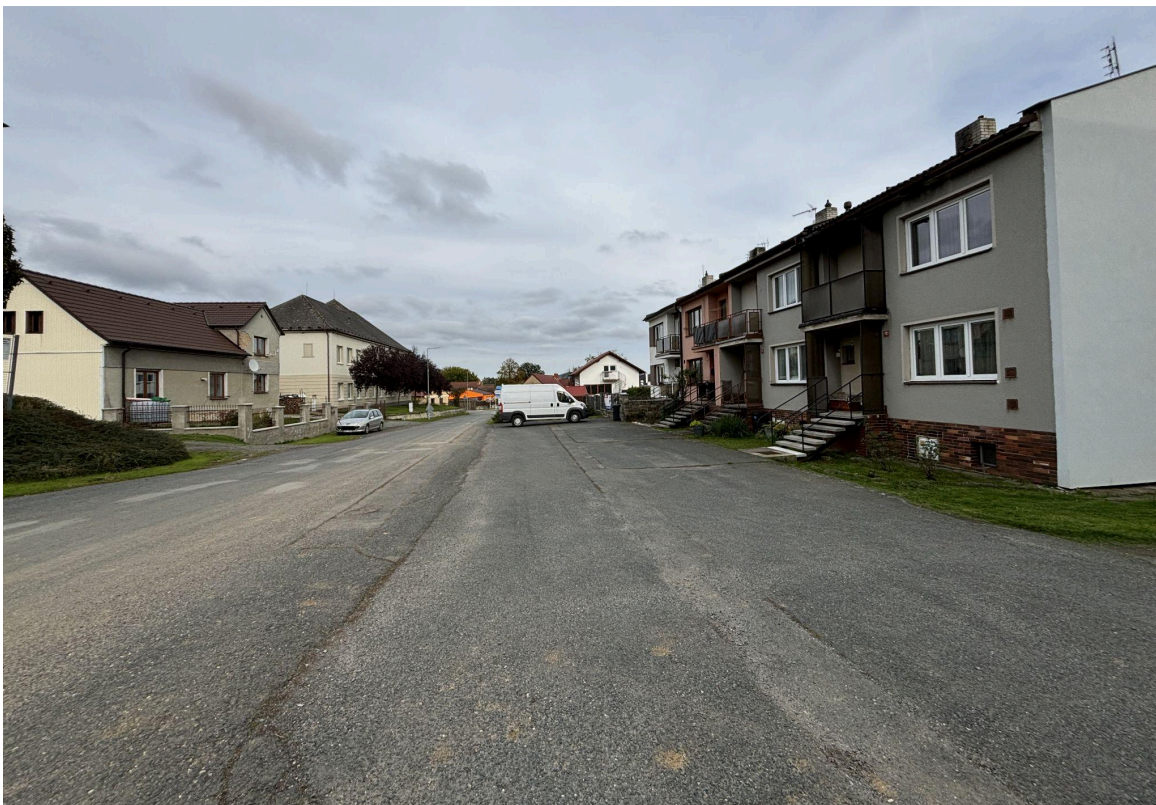
Obr. 11 - Velká zpevněná plocha v Kvíčovicích, kterou doporučujeme rozčlenit a přeměnit na propustný povrch (např. tzv. vegetační dlažbu s vyšší spárrou).
