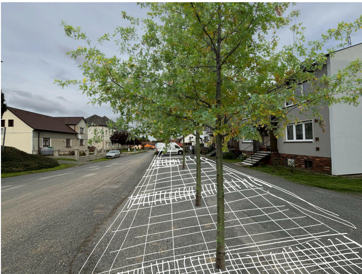
Obr. 14 - V případě doplnění podkladního souvrství pod zpevněnými plochami o tzv. podzemní rýhu a využití strukturálních substrátů je umožněna výsadba stromů nebo jiných forem vegetace přímo ve zpevněné ploše (např. s použitím kovovým mříží kolem kmene). Takové opatření pomůže zlepšit místní mikroklima - nejenom omezením přehřívání formou stínění, ale také výparem vody skrze listy rostlin a tudíž i ochlazením bezprostředního okolí.
