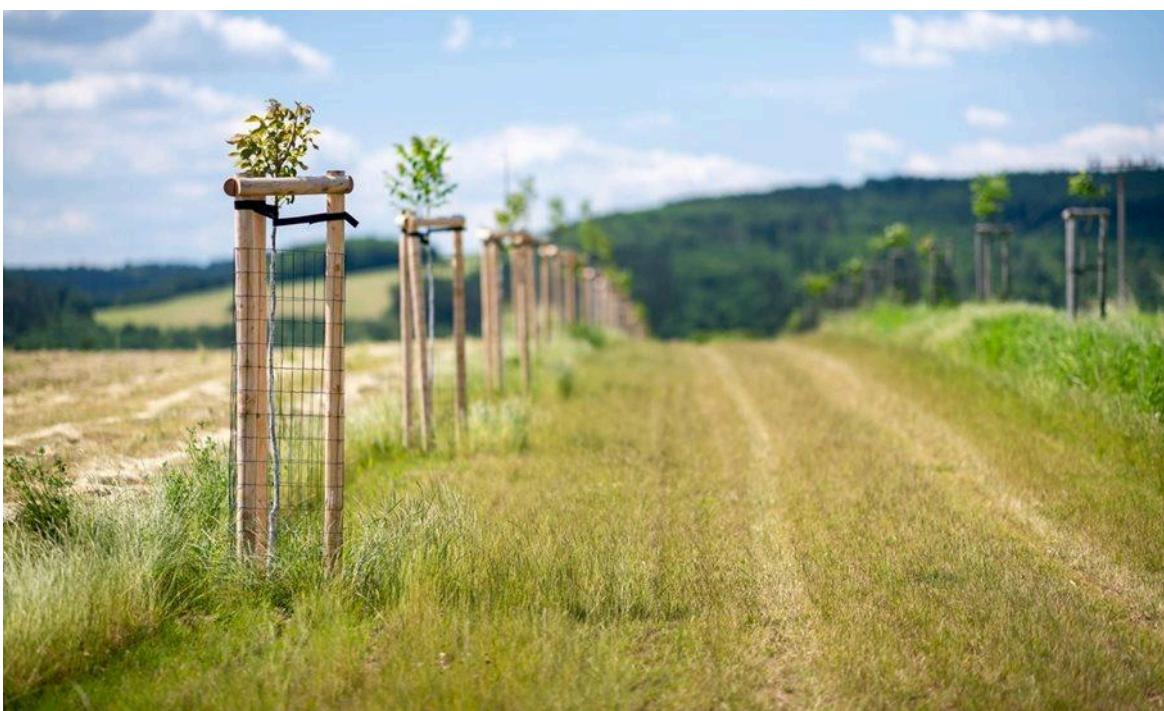
Obr. 33 - V místech, kde je potřeba umožnit pojezd těžké techniky, se může realizovat zatravněná zpevněná cesta jako ve Vohančicích - formou tzv. štěrkového trávníku (Zdroj: Adapterra awards)
