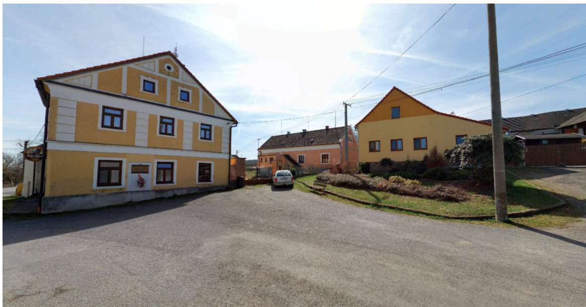
Obr. 49 - Zpevněná plocha před obecním úřadem v Bukovci by zasloužila celkovou revitalizaci
