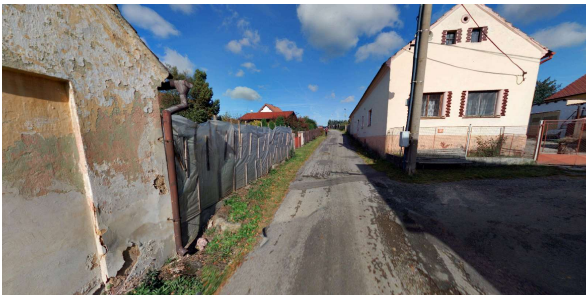
Obr. 61 - Svod z okapů na ulici v blízkosti vpusti dešťové kanalizace, Neuměř
