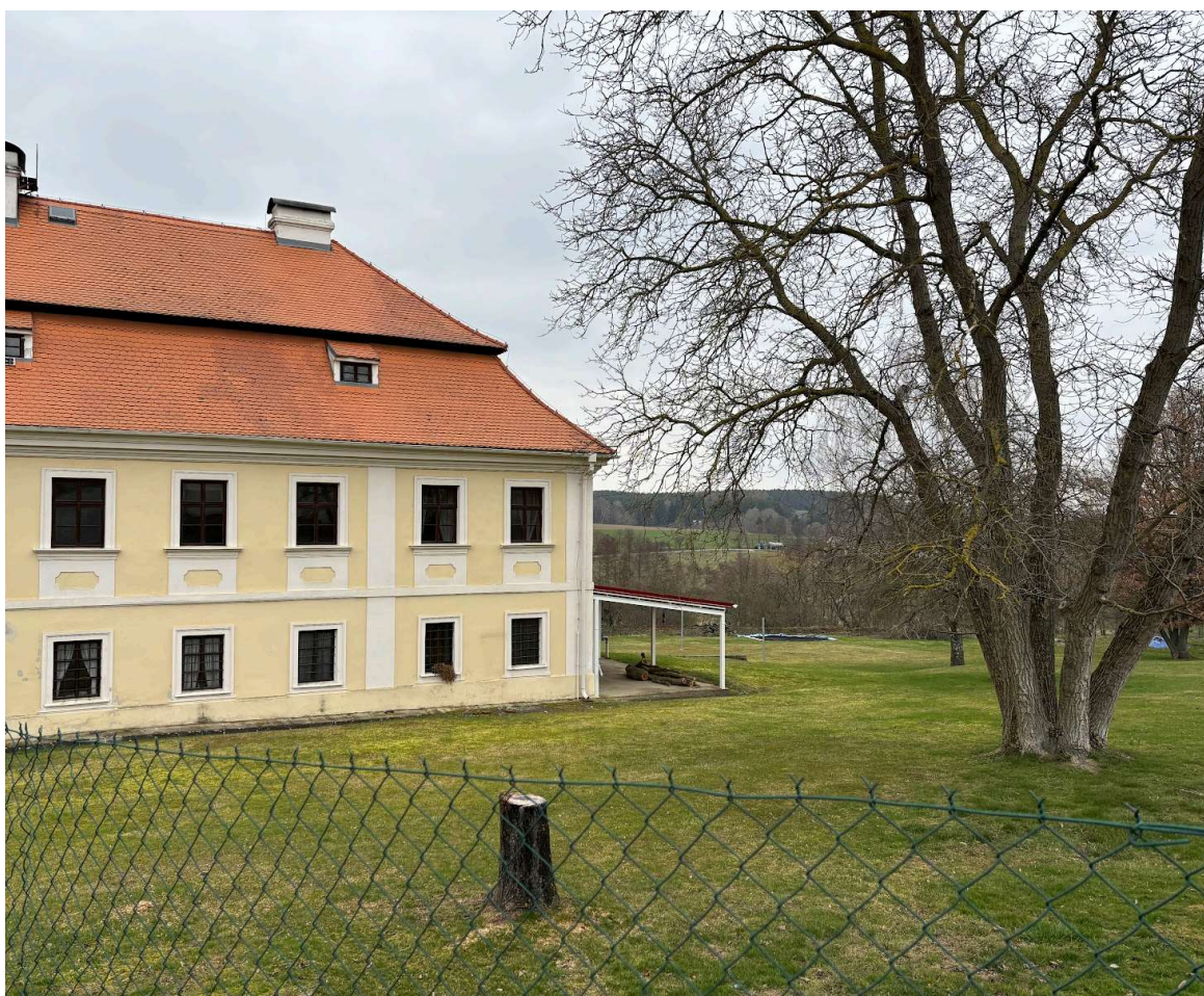
Obr. 14 - Opravený zámek (bývalá fara) v Bukovci. Zámek není zmíněn jako hodnota v územním plánu obce
