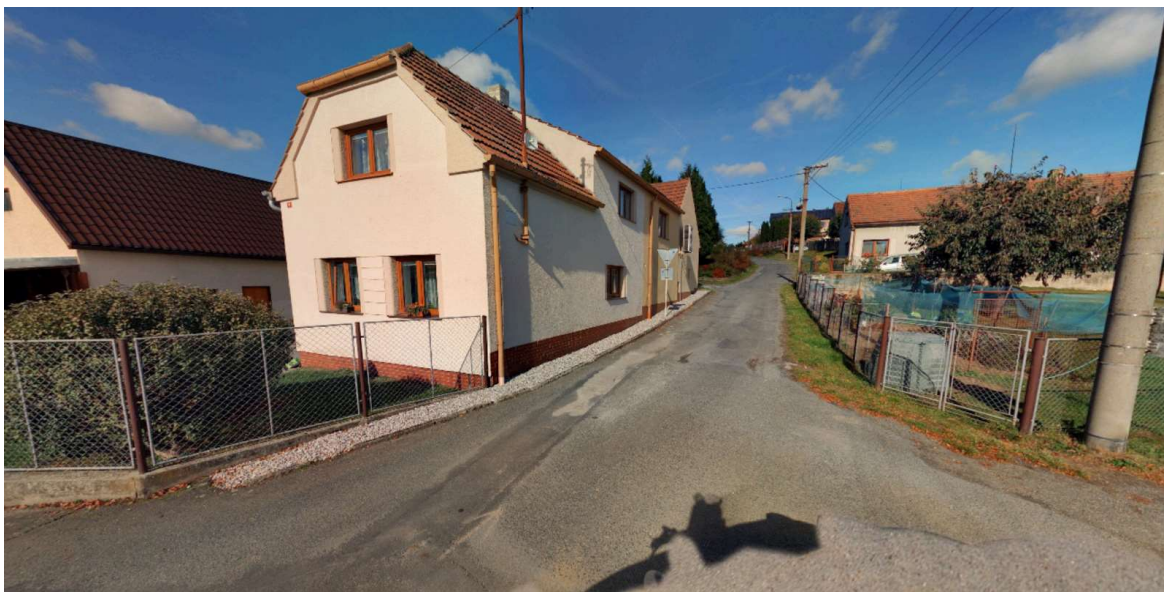
Obr. 60 - Napojení vody ze střech některých soukromých budov v Neuměři přímo do dešťové kanalizace
