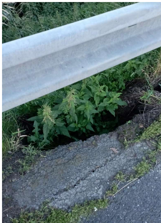
Obr. 127 a 128 - vlevo: přetékačící hráz horního rybníka v Čečovicích, ohrožení níže položených pozemků přívalovými dešti; vpravo: přetékačící hráz Ostromečského rybníka způsobuje trhání asfaltu na druhé straně vozovky (18.6. 2024)
