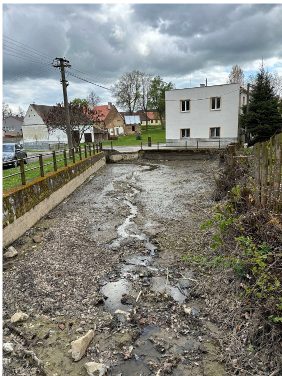
Obr. 131 a 132 - vlevo: problém sedimentace vodních nádrží v Neuměří (17.4.2024); vpravo: velké bloky orné půdy a prázdný horizont severně od Bukovce (7.3.2024, Bukovec)
