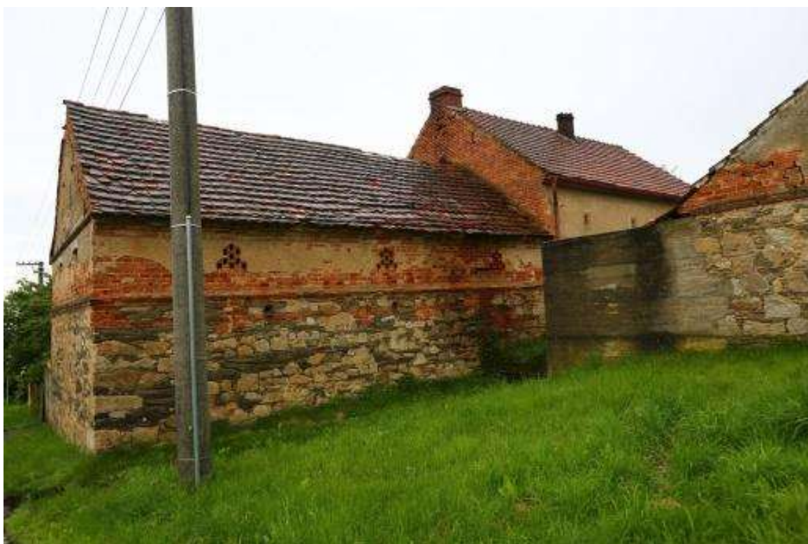
Obr. 79 - Smíšené zdivo na objektu v Pocinovicích
