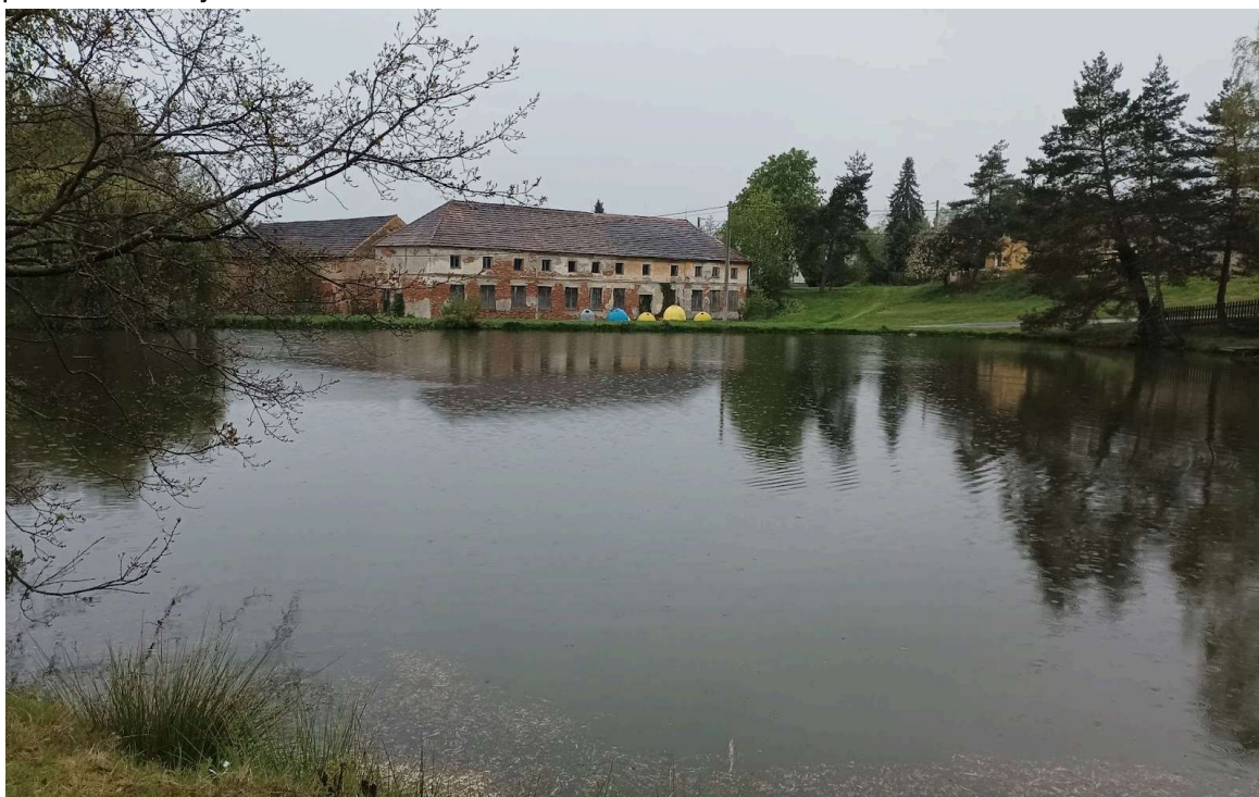
Obr. 96 - Rybník je dominantou obce, ale chátrající stavby a kontejnery kazí celkový dojem
