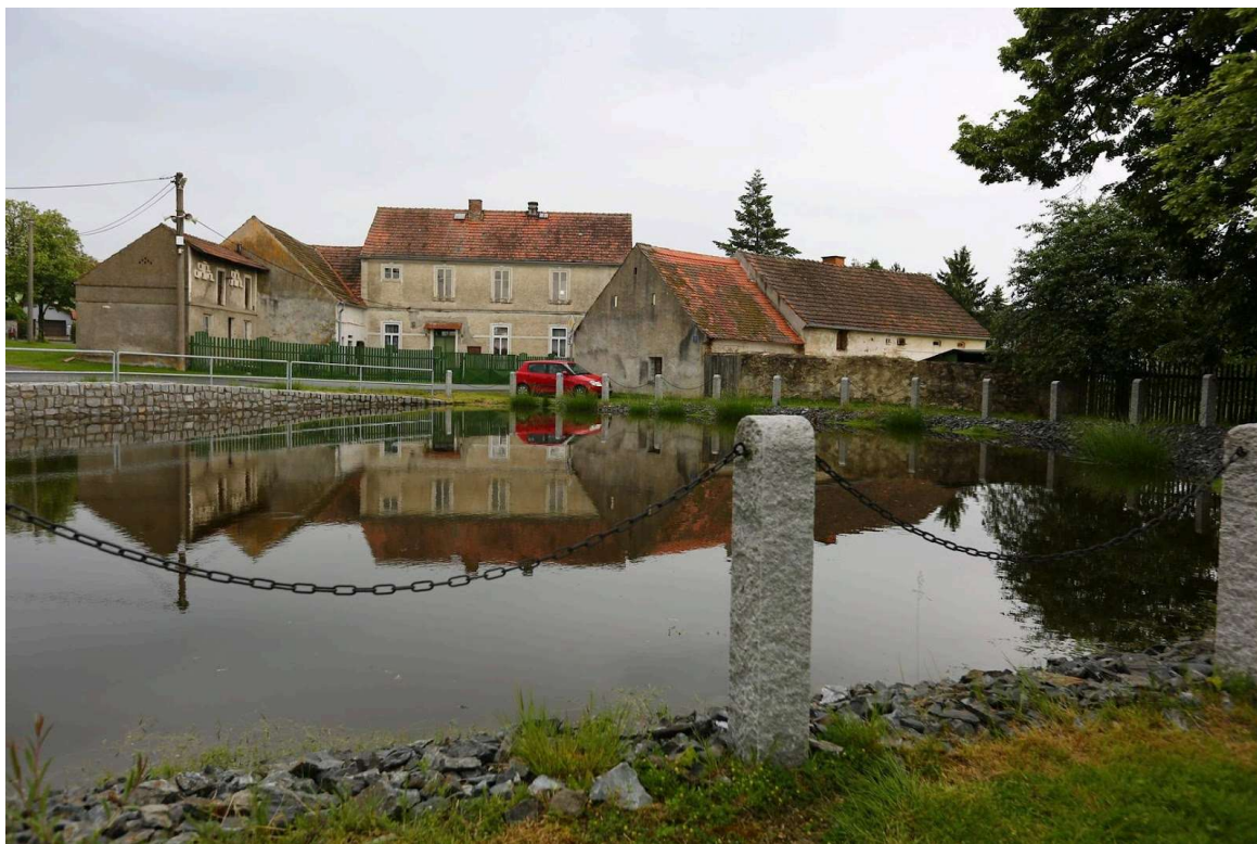
Obr. 77 - Vodní nádrž v Ostromeči
