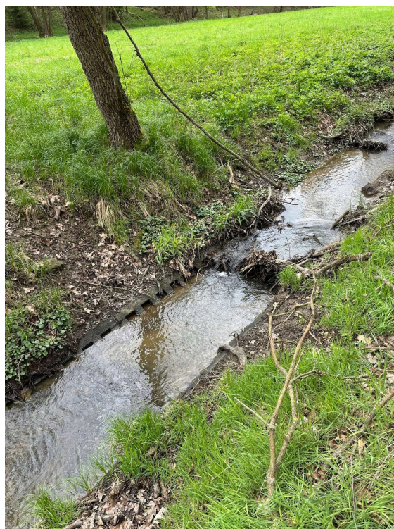
Obr. 129 a 130 - Vodní tok je téměř v celé délce napřímen, což přináší problémy s urychlením odtoku; vlevo: intravilán obce Neuměř, vpravo: koryto Chuchly pod Ostromečí (19. a 20.4.2024)
