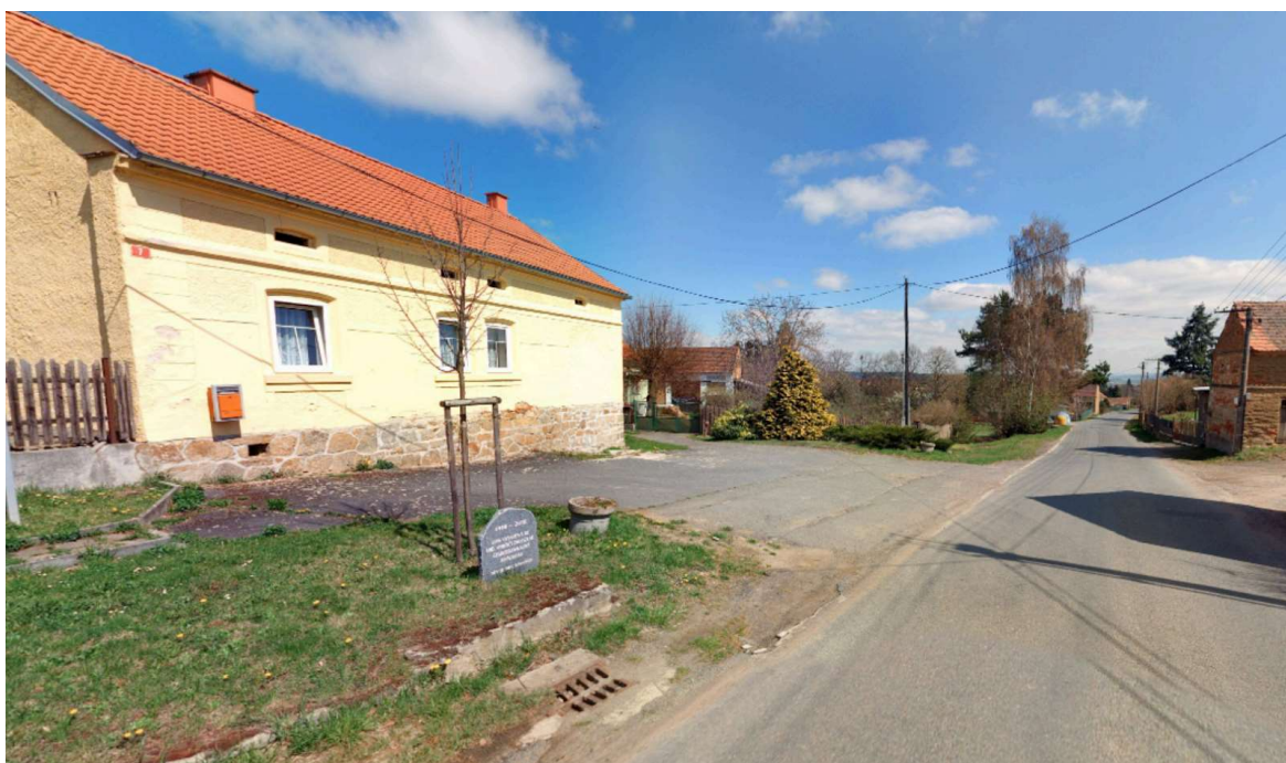
Obr. 65 - Vpust' dešťové kanalizace u kaple v Pocinovicích
