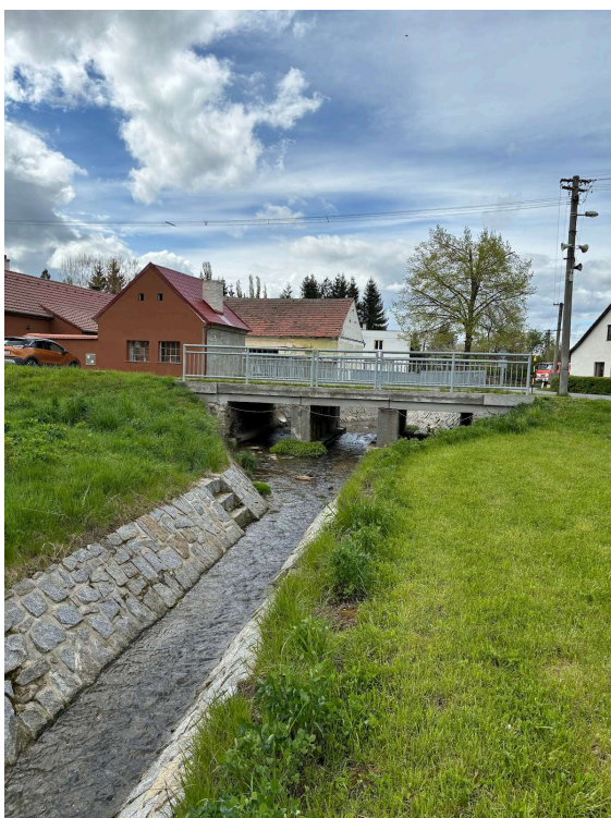
Obr. 129 a 130 - Vodní tok je téměř v celé délce napřímen, což přináší problémy s urychlením odtoku; vlevo: intravilán obce Neuměř, vpravo: koryto Chuchly pod Ostromečí (19. a 20.4.2024)
