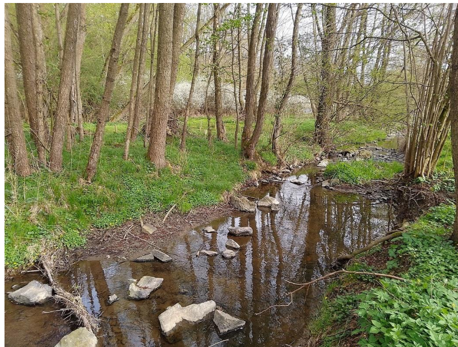
Rozšířené renaturalizující se koryto s dřevinami v břehové čáře pomáhající v morfologickém rozčlenění koryta toku.
