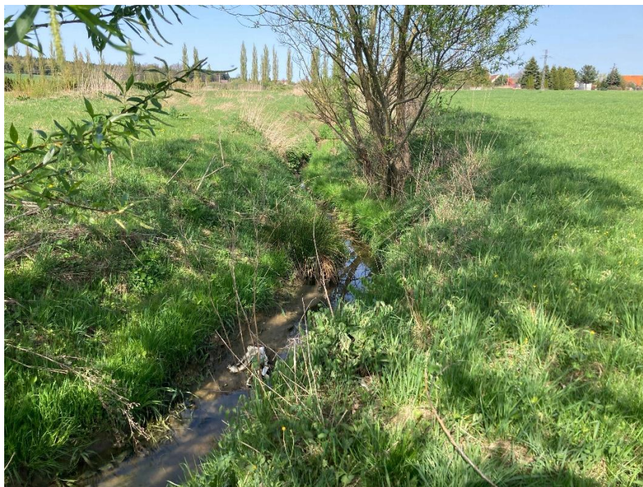
Vodní tok pod čistírnou odpadních vod, se silným nánosem sedimentů a výskytem splaškového odpadu.
