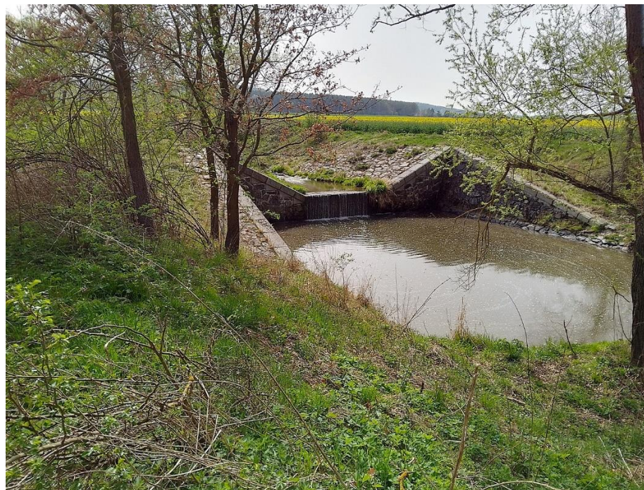
V úseku se nachází po 100 a 150 m několik kamenných stupňů s převýšením hladin 0,4 – 1 m, na obrázku výše kamenný stupeň s převýšením hladin min. 1 m v ř. km 2,337.
