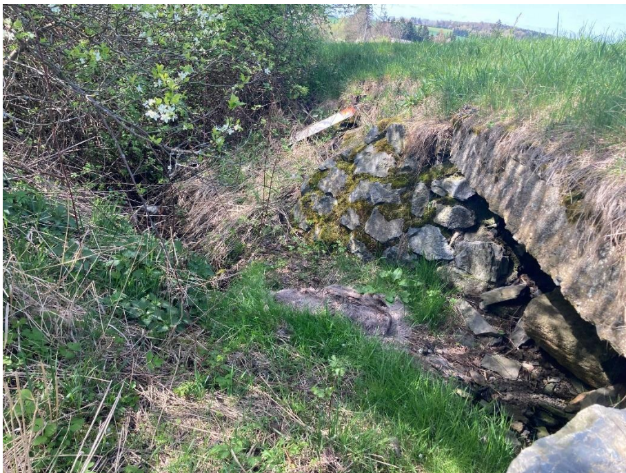
Evidovaný začátek vodního toku správcem povodí, most pod silnicí II/230.
