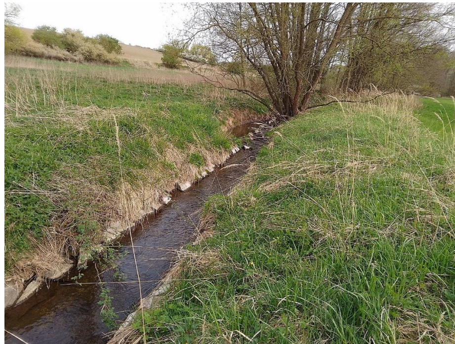
Část úseku ze zachovalou významnou stabilizací vodního toku napřímením a opevněním.
