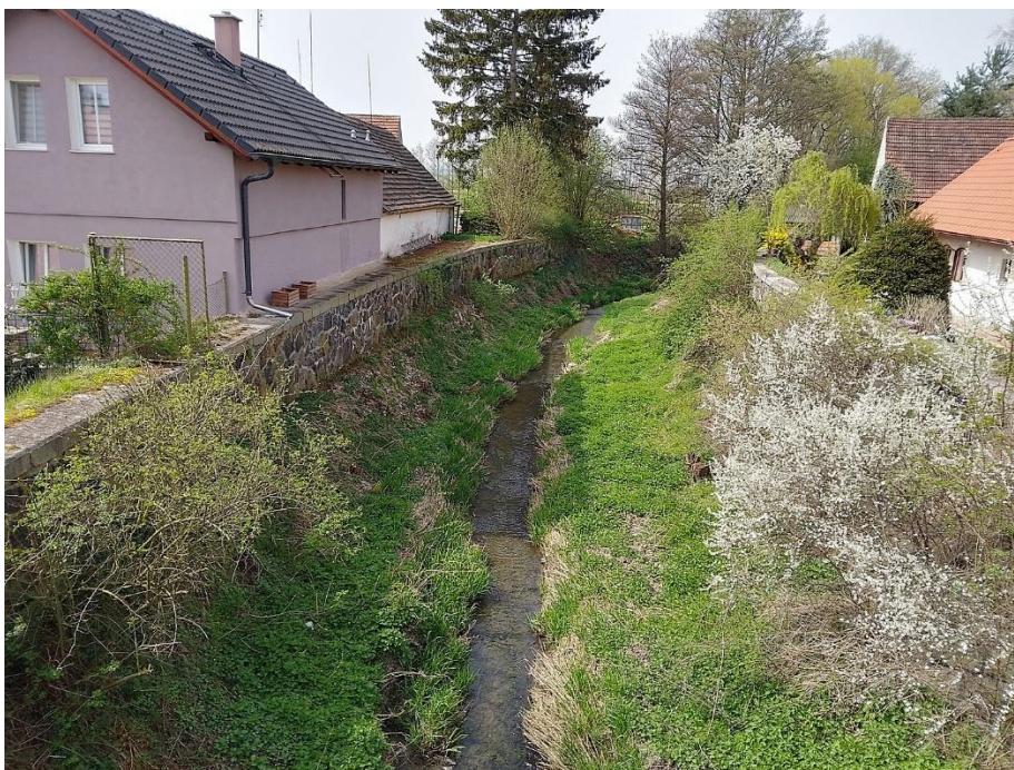
Lichoběžníkové koryto s opěrnými zdmi v Radkovicích.
