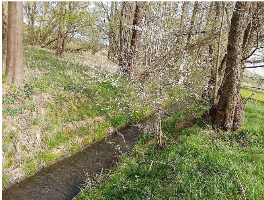
Viditelně upravené prizmatické koryto bez morfologické členitosti a přirozené dynamiky vodního toku.
