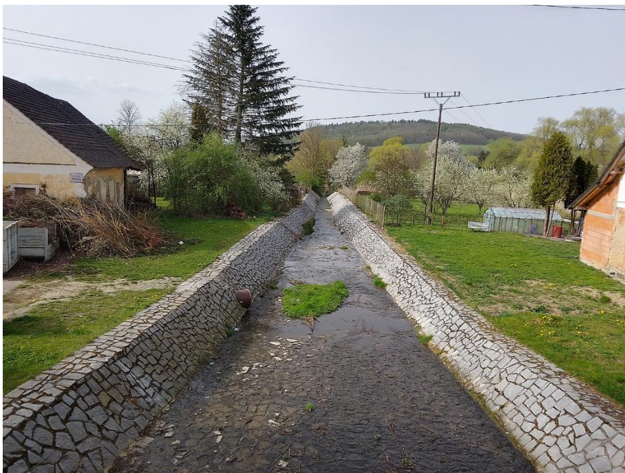
Krátký opevněný úsek břehů i dna toku dlažbou z lomového kamene.
