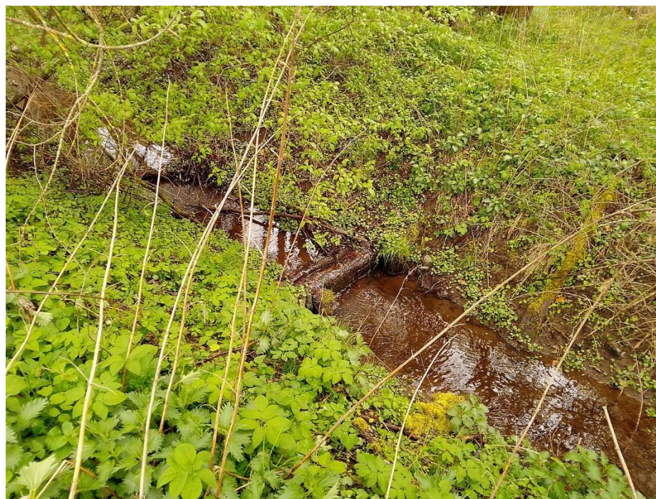
Koryto toku je stabilizováno dřevěnými kulatinami o výšce 30 cm.
