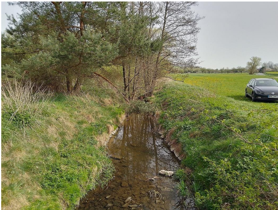
Upravené koryto toku do lichoběžníkového tvaru, po levém břehu mezofilní louka, v úseku nejsou významné překážky rozlivu v případě revitalizace úseku toku.
