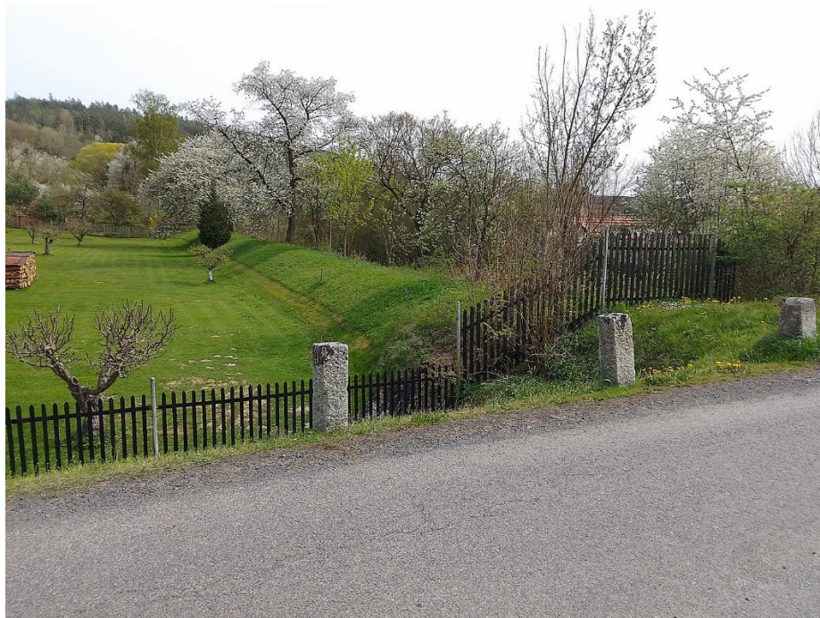
Protipovodňový val po pravém břehu v Radkovicích.
