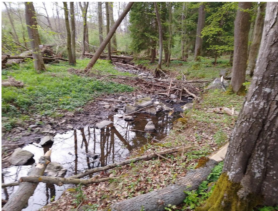
Úsek toku s velkým množstvím spláví a balvanitým sedimentem.
