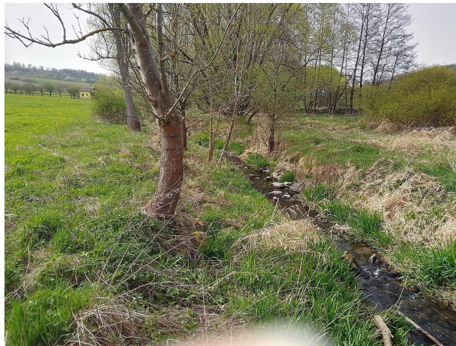
Vegetací zarostlé paty svahu s uvolněnými kameny z opevnění.
