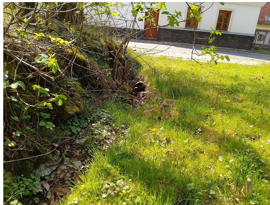
Začátek úseku toku, zaklenutí o průměru 30 cm.
