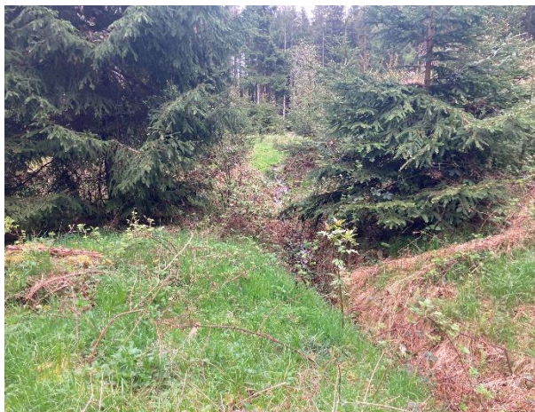
Foto 18: Páteřní odvodňovací koryto (IDVT 10264779) lichoběžníkového profilu odvodňuje okolí
