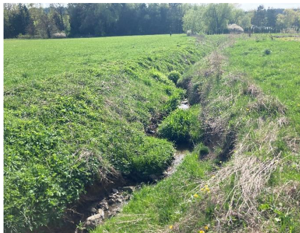
Foto 15: Otevřené hlavní odvodňovací zařízení lichoběžníkového příčného profilu s příznaky samovolné renaturace
