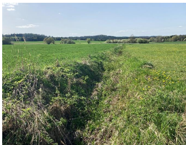
Foto 13: Otevřené hlavní odvodňovací zařízení lichoběžníkového příčného profilu, zahlobené, rychle odvádí vodu z okolních polí a luk
