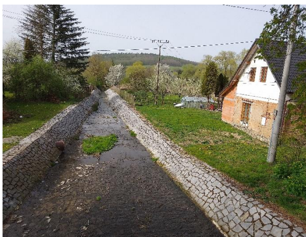
Foto 5: Výust' jednotné kanalizace do Zlatého potoka pod Horšickým rybníkem
