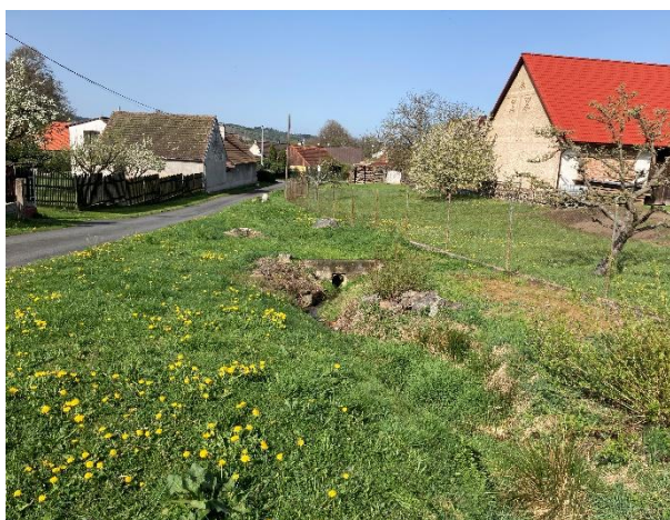
Foto 25: Vpust DN 400 do jednotné kanalizace Újezdu u Horšic, která je zatěžována extravilánovými vodami (KB Újezd u Horšic)
