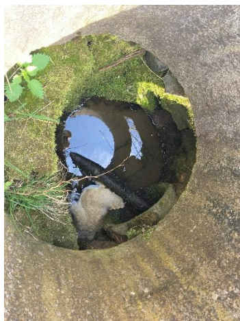
Foto 14: Vyústění hlavníku v meliorační šachtě
