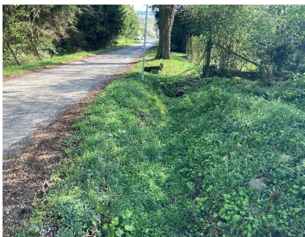
Foto 21: Někapsitní vpust do jednotné kanalizace před Horšicemi, kam jsou svedeny srážkové vody z asfaltové komunikace (KP4)
