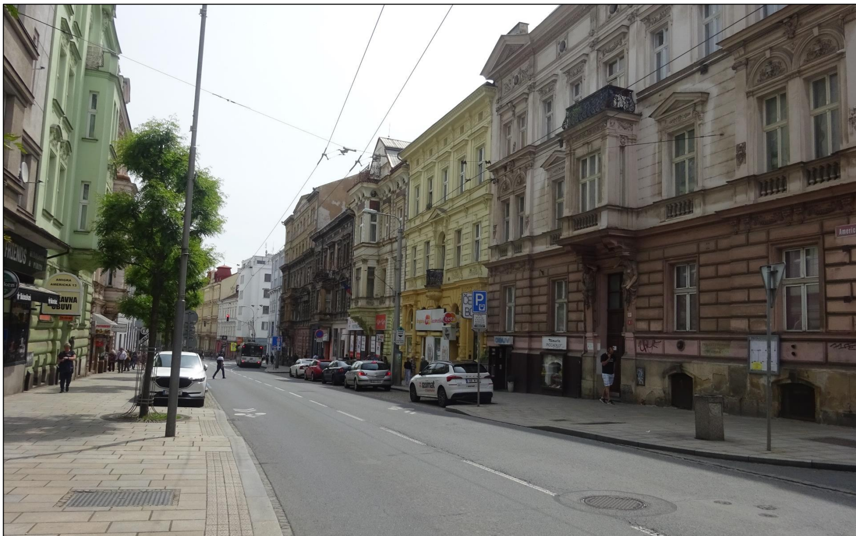
Obr. 14: Fotodokumentace zástavby v ulici Americká, pohled směrem na východ od křižovatky s ulicí V Šípce (kritické místo priority I s označením AGPLRD009)
