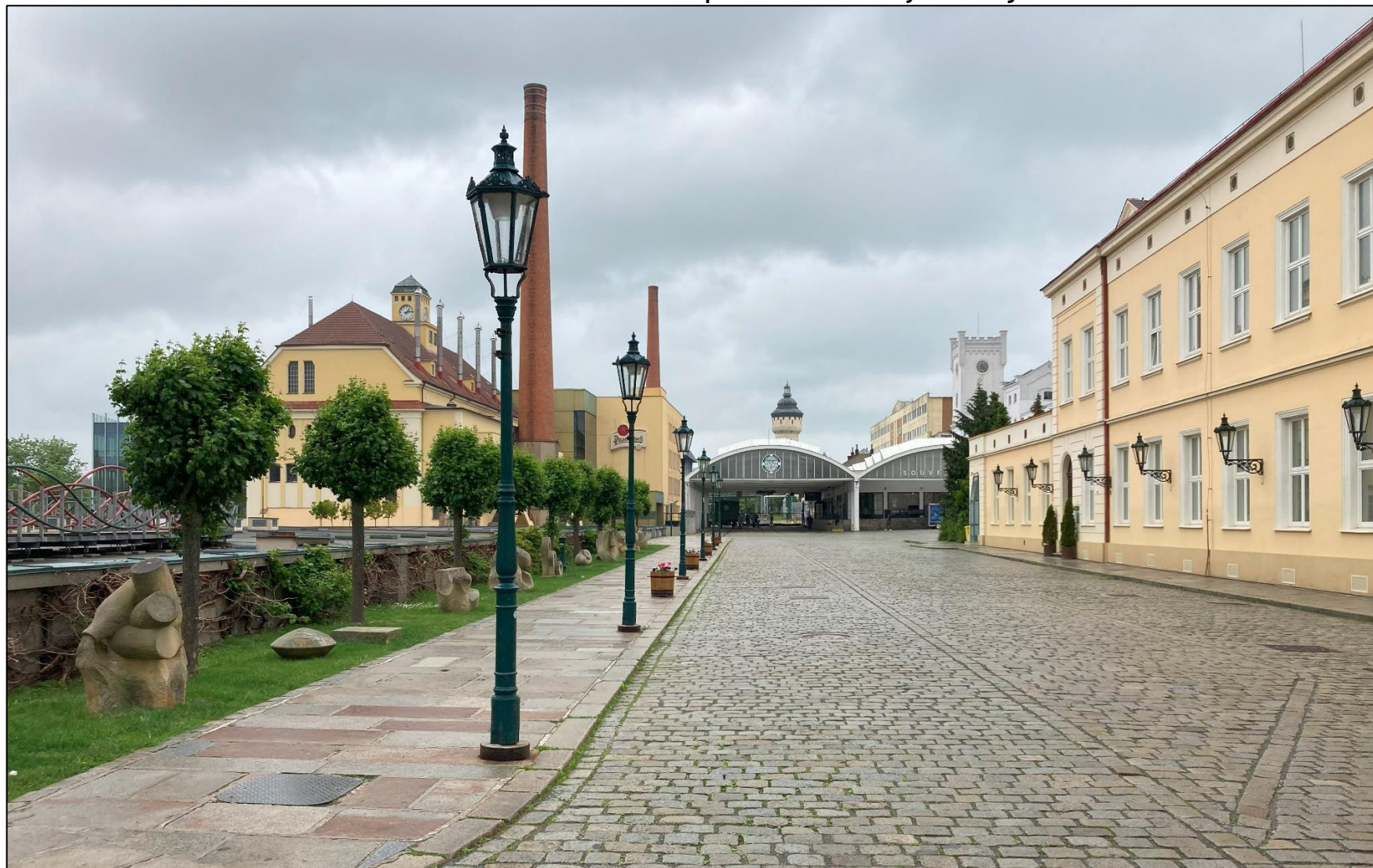
Obr. 19: Fotodokumentace areálu společnosti Plzeňský Prazdroj a. s.
